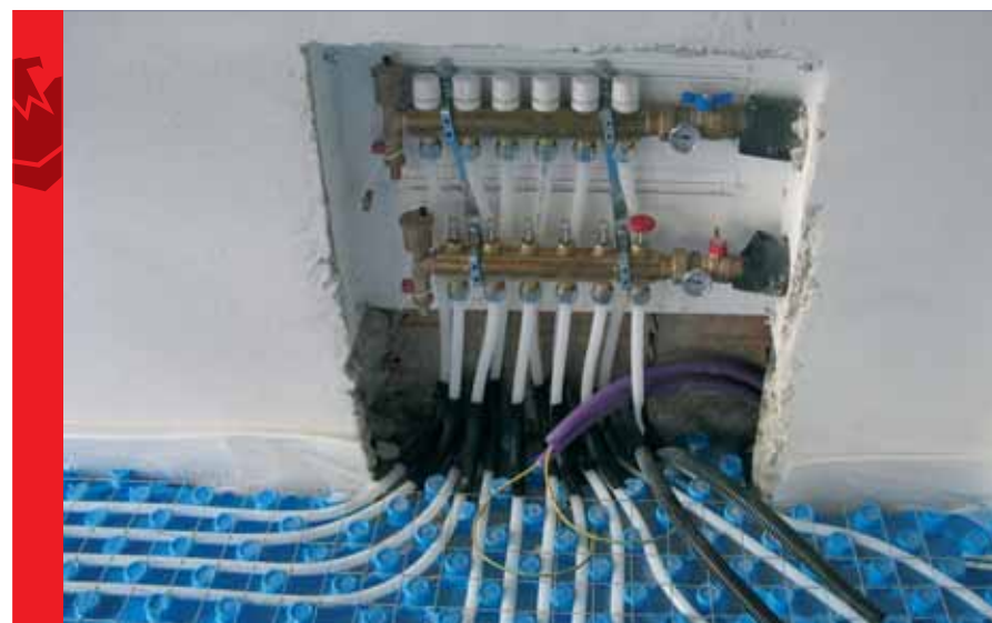
Impianto a pannelli radianti con TUBORAMA PE-X
